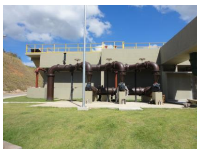
ETE OLARIA - GUARAPARI RETORNO DE LODO DECANTADO
