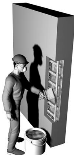
Figura 5 – Aplicação da proteção anticorrosiva nas armaduras
