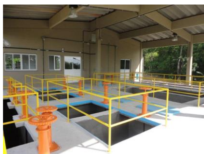
ETA VIANA FLOCULADOR, DECANTADORES E FILTROS
