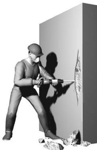
Figura 1 – Demolição superficial do concreto
