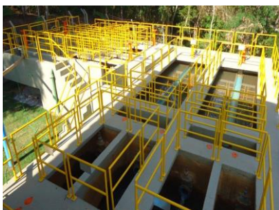
ETA IBATIBA FLOCULADOR, DECANTADORES E FILTROS
